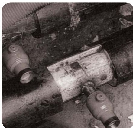
2. POSITIONNEMENT, SOUDAGE DE LA VANNE
