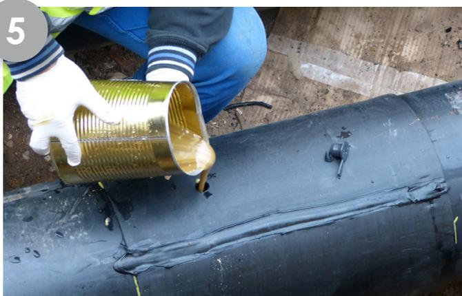
L'isolation est réalisée en mélangeant les composants de la mousse polyuréthane puis en versant le mélange dans la jonction.
