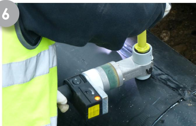
Afin d'assurer une étanchéité à toute épreuves, les trous nécessaires à l'injection de la mousse PU sont ensuite scellés par soudure d'un bouchon en PE.
