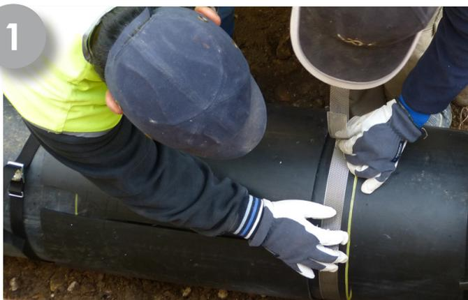
Après avoir correctement nettoyé et dégraissé les surfaces à souder (gaine et manchette). Des grilles de soudure sont ensuite installées et maintenues sur la gaine du tube, la manchette PEHD est coupée longitudinalement puis mise en place.
