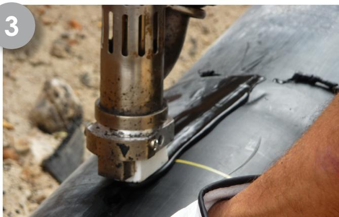
Pour parfaire l'étanchéité de la jonction, la coupe longitudinale de la manchette est soudée par extrusion de PE.
